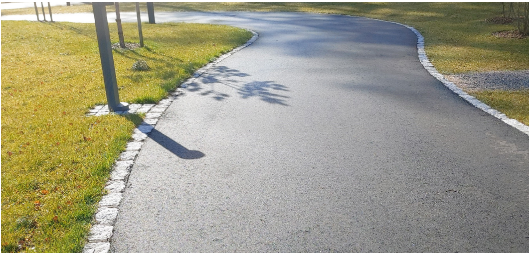
Referansebilde: Gangvei med asfalt i grøntanlegg. Kantstein skal normalt være i plan med veidekket. Drenering med 2% tverrfall til plen. Veien skal være ca. 5 cm høyere enn gjennomsnitt av terreng. Merk jevn og fin linjeføring for kanter. Torridal gravplass 2019.
