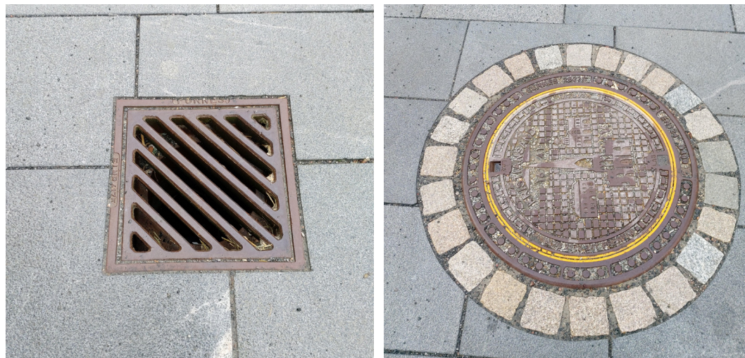
Referansebilde: Kvalitet på utførelse og tilpasninger av granittdekke, med og uten gatestein mot sluk/kum. Dersom gatestein benyttes ved sluk, fuges denne med mørtel. Torvet 2020, Kristiansand.
