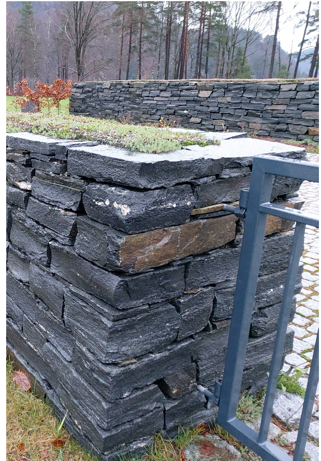
Referansebilde: Tosidig tørrmur med sedummatte, høy kvalitet. Øvre steinsjikt, ca. 30 cm, er bundet sammen med mørtel. Torridal gravplass 2020.
